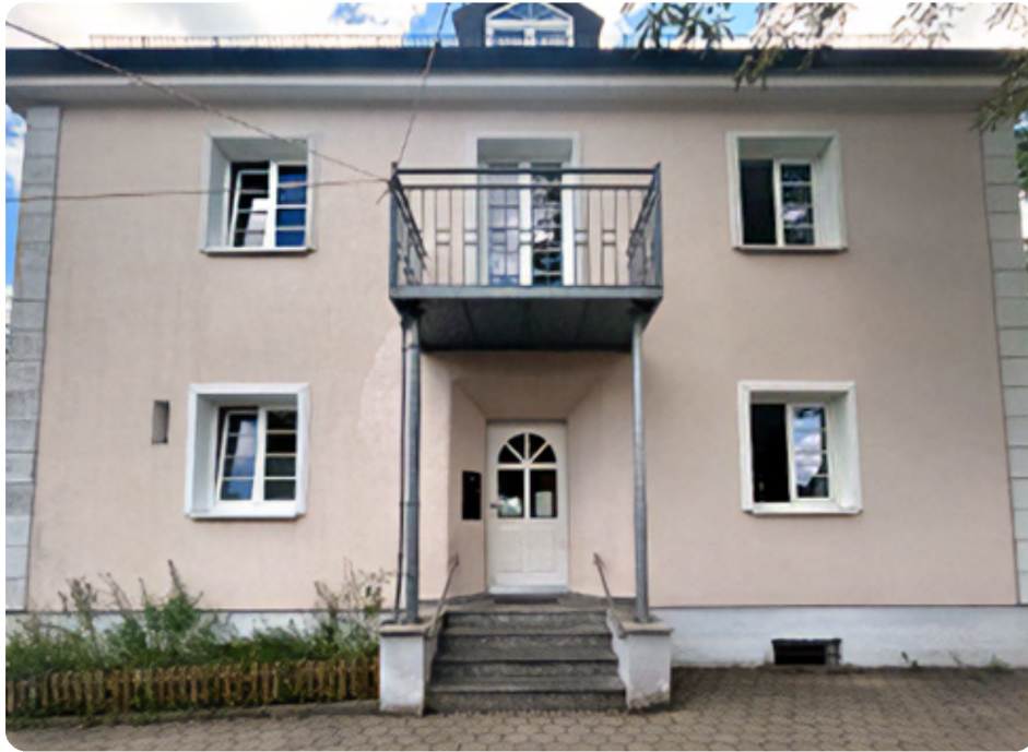
Abbildung 1: Das Haus am Authariplatz 9 beherbergt die Raupengruppe im Erdgeschoss und die Igelgruppe in der 1. Etage.
